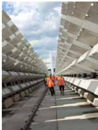
Bild: Baubetrieb im Vormarsch
