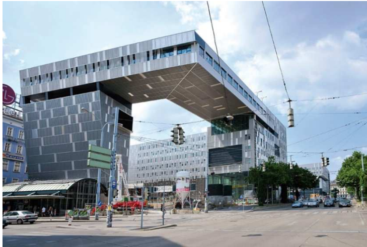
Abbildung 3: Wiener Westbahnhof nach dem Umbau 2011
