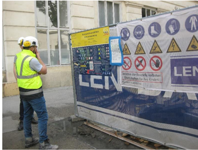
Abbildung 2: Tafel mit Sicherheitshinweisen und Telefonnummern am Bauzaun
