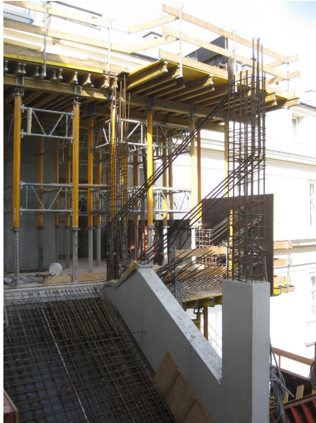
Abbildung 5: Unterstellungen und Bewehrung der neuen Stiege 10
