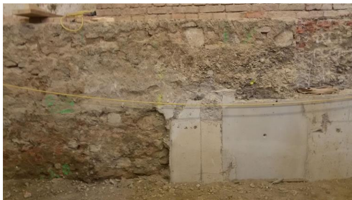
Abbildung 4: Höhengsprung im Bestandsfundament
